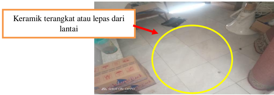
Gambar 5 : lantai masjid Al-Ikhlas
